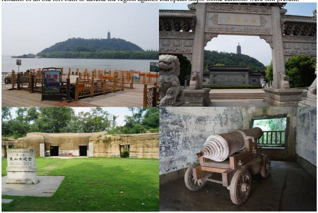
焦山古炮台位于焦山东麓,由八个炮堡和一个大弹药库组成,堡身以青石为基,圆木 为骨, 用黄泥、石灰、糯米汁捣成三合土, 层层夯筑而成。
