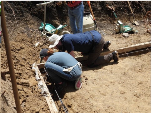
Tying edge rebar
