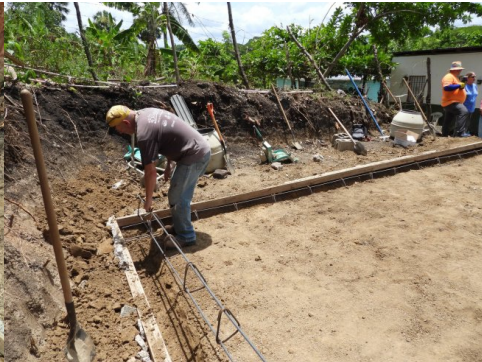
Inserting edge rebar
